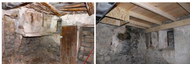
Gîte de Notre-Dame de Lauzière, le Brusquet. Avant travaux/Après travaux © E. Loubinoux
