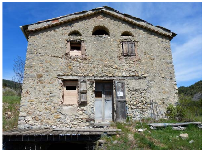
Gîte de Sévigné après aménagement, Draix © M. Tetu
