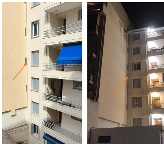
Figure 1. - joint de dilatation (flèche orange) entre deux bâtiments de la ville de Nice, abritant la colonie reproductrice de Molosse de Cestoni ayant fait l'objet d'un épisode de mortalité et morbidité de juvéniles répété en 2022 et 2023. Vue de jour à gauche et de nuit à droite. Crédits : GCP, septembre 2022
