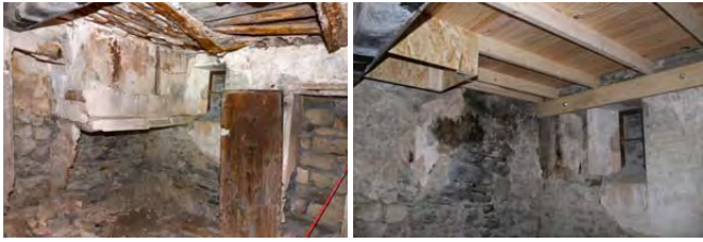
Gîte de Notre-Dame de Lauzière, le Brusquet. Avant travaux/Après travaux © E. Loubinoux
